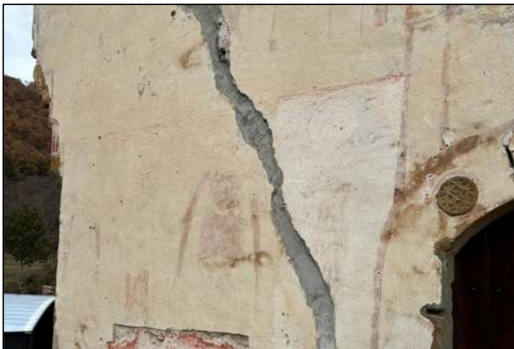
Фиг. 6. Повредени стенописи върху фасадата на църквата. Забелязва се запълването на пукнатината върху стената. Личен архив, март, 2025 г.
