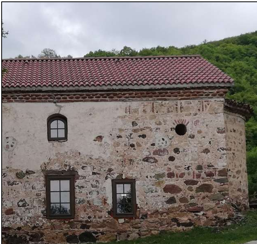
Фиг. 7. Ремонтният покрив на сградата и сменената дограма. Личен архив, 2019 г.
